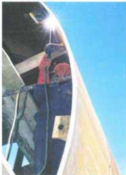
Fig. 1 – O trabalho de soldadura é por vezes muito dificultado pela exigência do espaço.
