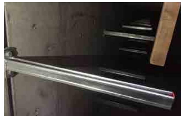
重庆江北机场管廊
