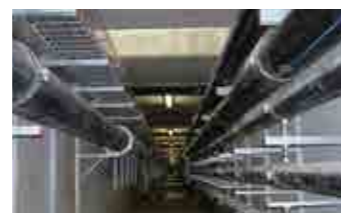
管道及桥架固定
