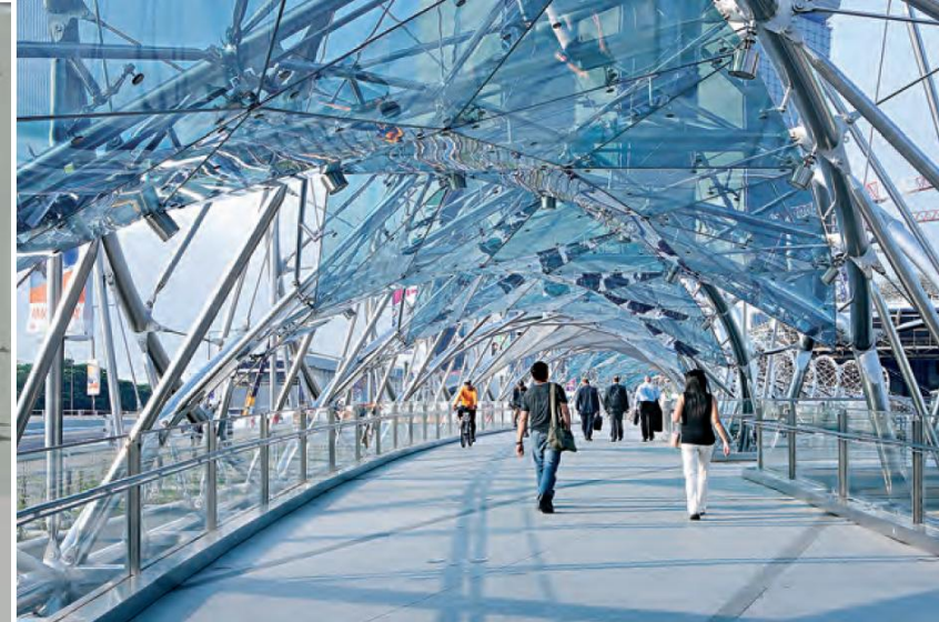
„The Helix“, Singapur, mit einem Tragwerk aus dem Duplexstahl EN 1.4462 (2205) (Quelle: Financial Dynamics/C. F. Jones)
