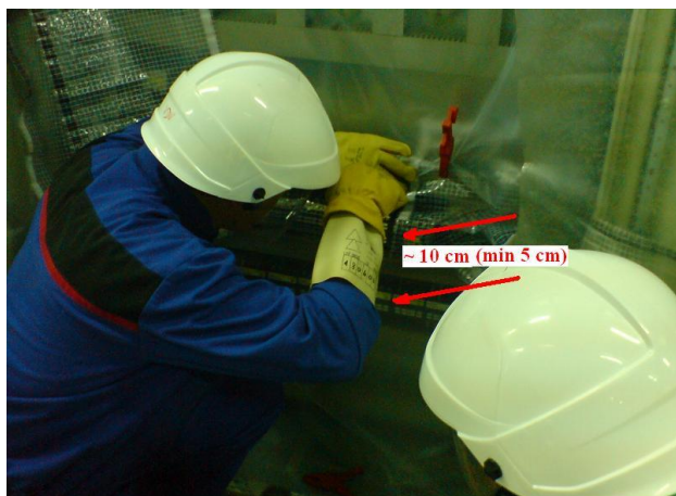
Slika 8. Pravilno nošenje kombinacije izolacijske rukavice i kožne nadrukavice [17]
