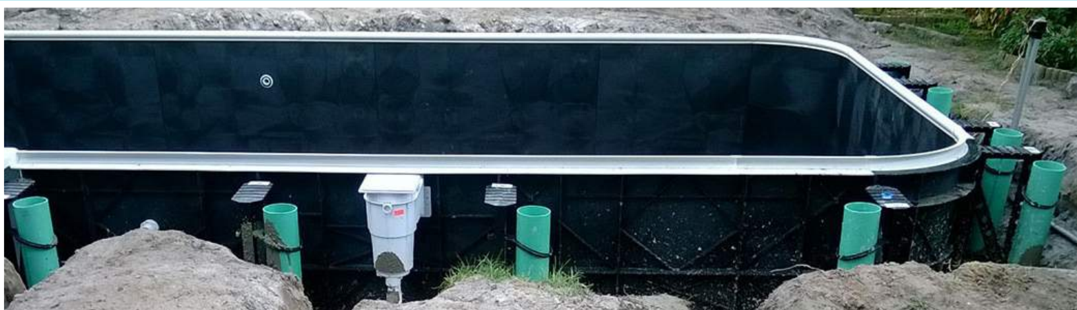
SONO TUBES PLACED AROUND POOL
