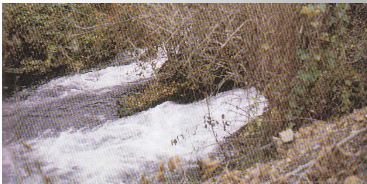
Le due paratoie ancor oggi esistenti dalle quali passava l'acqua forzata che faceva girare le ruote
