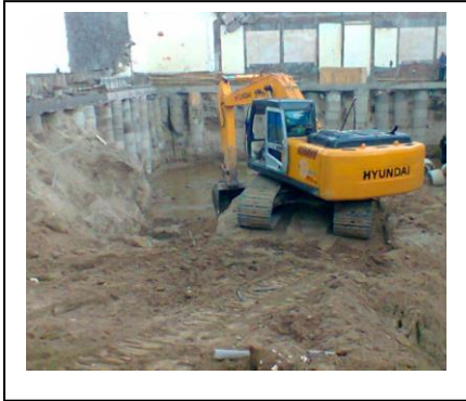
Gambar 3 : Pekerjaan Galian Tanah Basement
