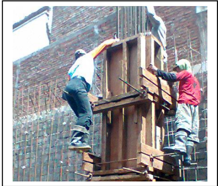
Gambar 6 : Pemasangan Begisting Kolom
