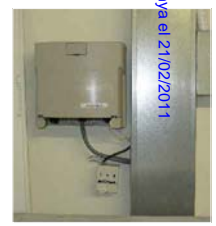
FOTO EJEMPLO CAJA TELEFONIA INTERCONEXION PBx
