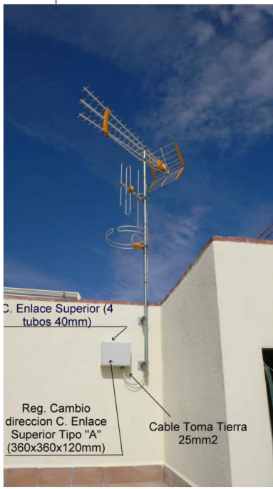
FOTO EJEMPLO ANTENA MASTIL CON GARRAS Y CAJA ESTANCA CAMBIO DE DIRECCION CANALIZACION ENLACE SUPERIOR
