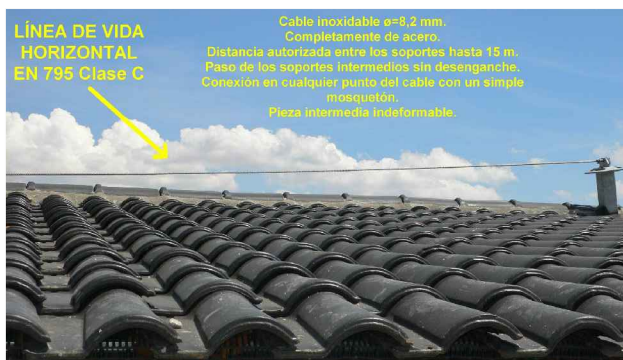
FOTO EJEMPLO LINEA DE VIDA HORIZONTAL EN 795 CLASE C
