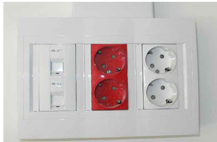
CAJA CIMA PRO GRAFITO 2D DE SUPERFICE CON 3 MODULOS SIMON CONNECT COMPLETO. 4 TOMAS ELECTRICAS SCHUCO Y 2 CONECTORES RJ45 CAT6 PARA "VOZI DATOS"
