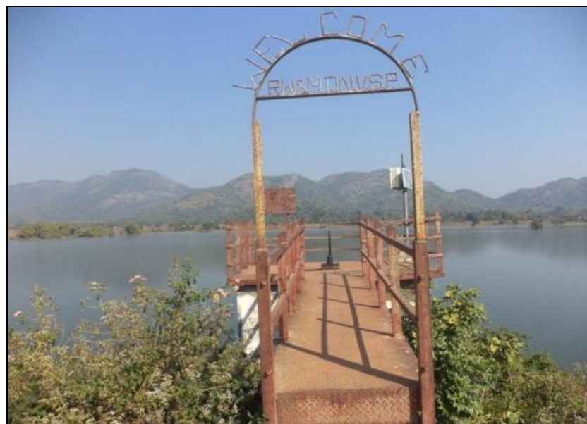
Fig 3: Kalinga Dal reservoir right canal gate
