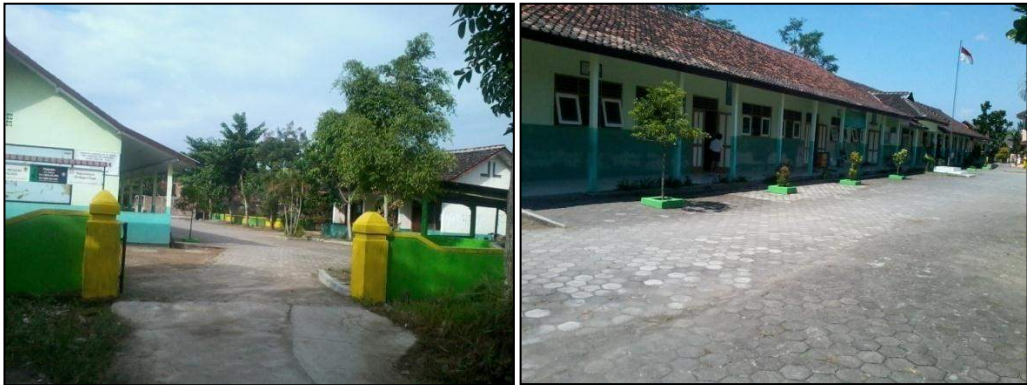
SD N Pojok dilihat dari depan dengan cat baru. Gapura gerbang tidak terlalu tinggi. Halaman sekolah yang cukup luas dan digunakan untuk upacara bendera setiap hari Senin.
