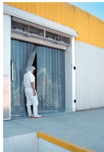
Aplicación Lama PVC y Cortina de Aire en bodega
