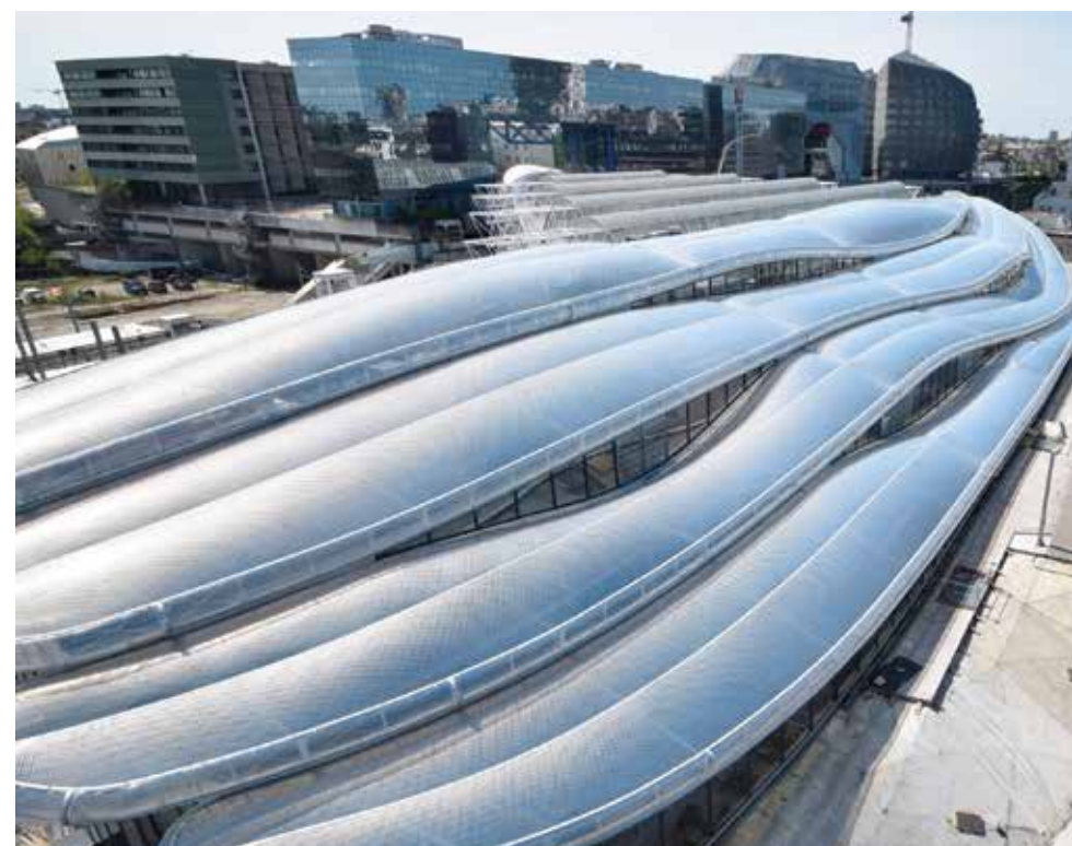
La toiture en ETFE
