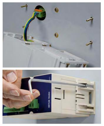
Figure A-13: Installing DIN Module
