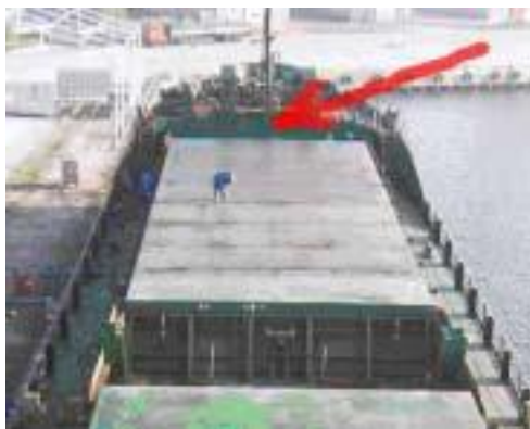
Fot. 3 „Mały anglik” zbudowany wg wymagań konwencji SOLAS 60 , z usytuowaniem awaryjnego zespołu prądowórczego niezgodnym z późniejszą konwencją – SOLAS 74 .
