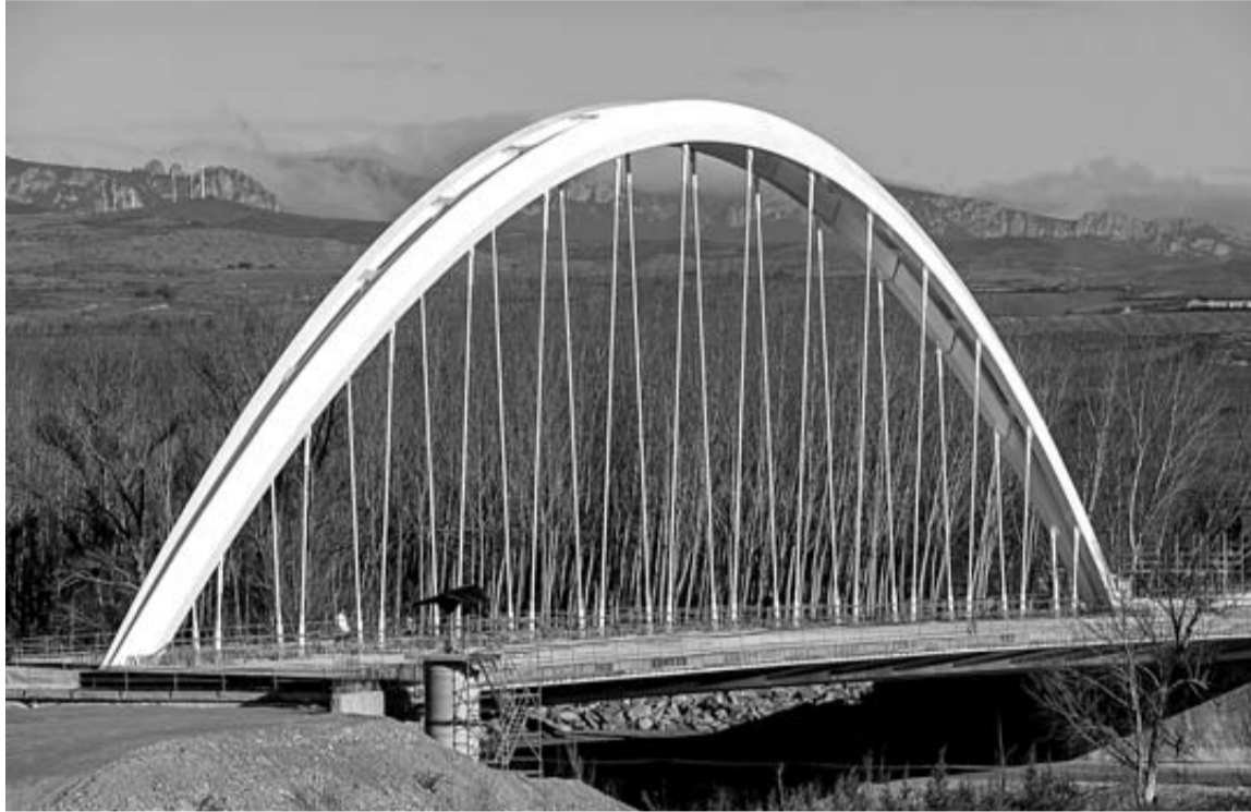
La estampa del nuevo puente, un arco metálico doble de 120 m. de luz apoyado en 14 tirantes dobles. Al fondo de la imagen se recorta la sierra de Codés. MONTXO A.G.
