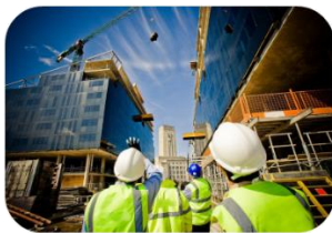
Suspensión/atrasos en la ejecución de obras
