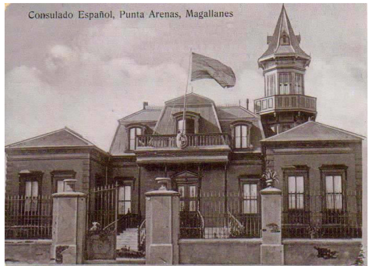
CON TORRETA DE MADERA AGREGADA
