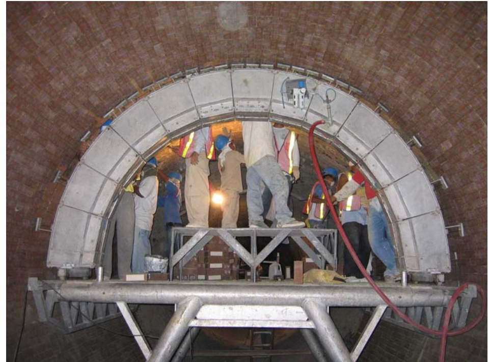
DAT Bricking Rig in operation
