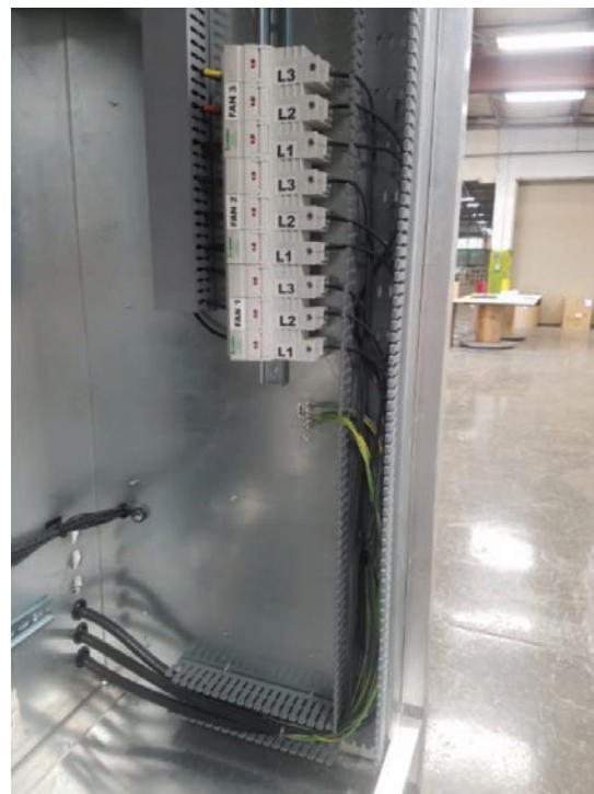
Figure 28. Fan power terminations
