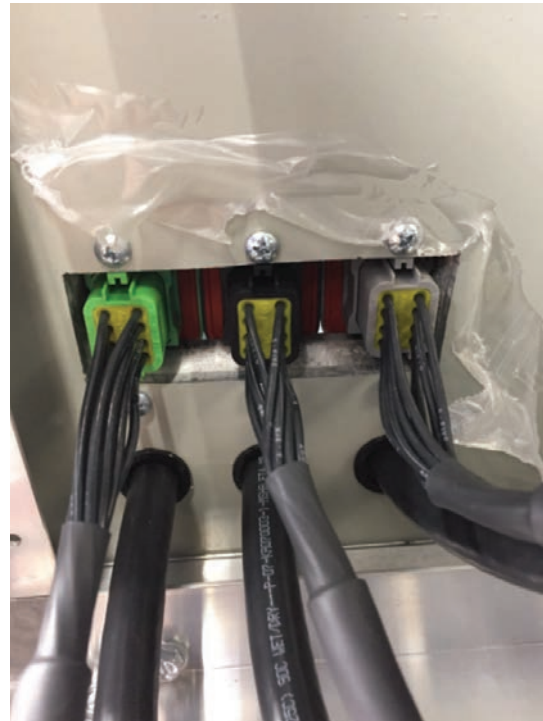
Figure 28. Fan power terminations
