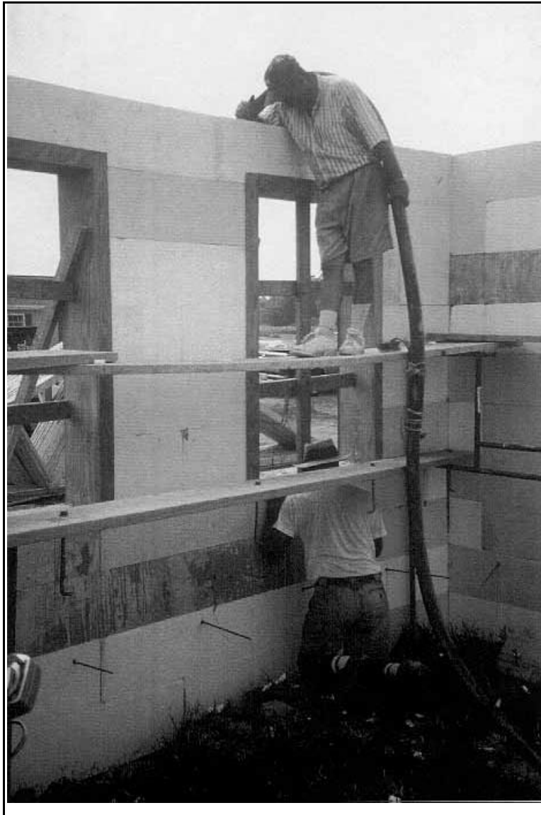
Photo 52: Site #4 - Concrete Pour
