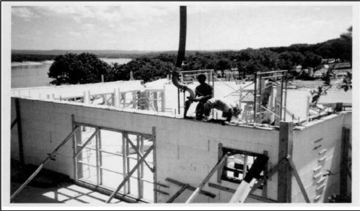
Photo 18: Site #2 - Concrete Pour
