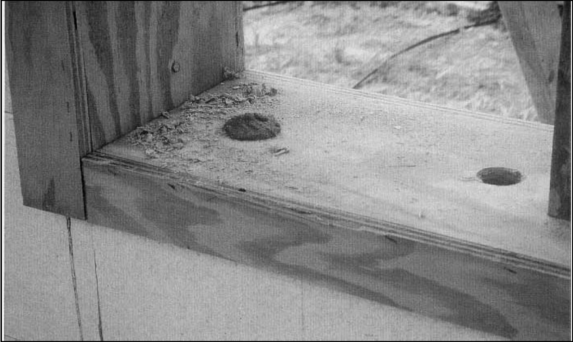
Photo 53: Site #4 - Concrete Pour at Window
