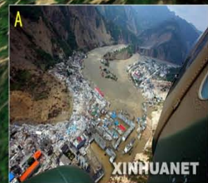
A图为2008年6月10日航拍的北川县城，唐家山堰塞湖泄洪造成县城部分淹没。
