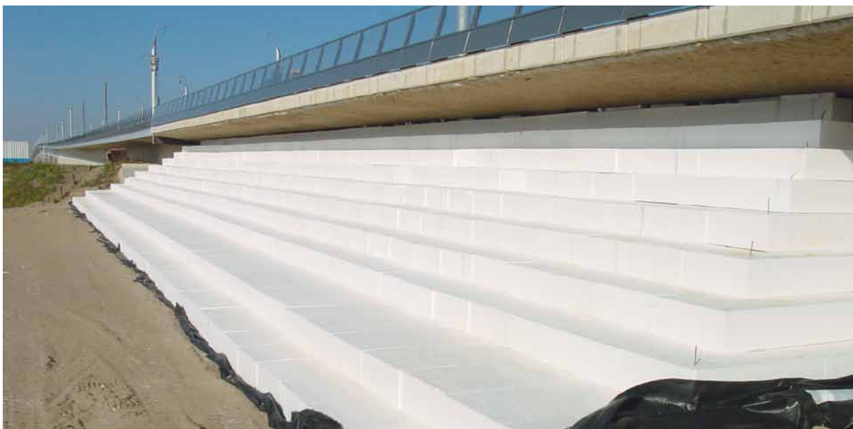
EPS als zettingsvrij materiaal bij HSL-brug Moerdijk
