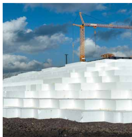
EPS als licht funderingsmateriaal bij grond-, weg- en waterbouw
