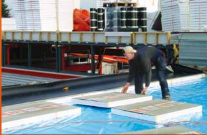
plat dak isolatie
