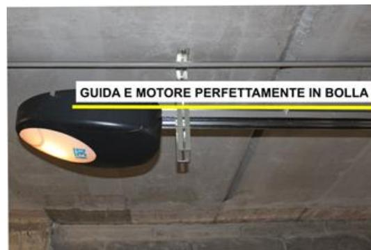
A terra, procedere all'assemblaggio della guida con il motore (vedi manuale in dotazione), fissandoli poi al celino della porta, in posizione centrale (lasciare dietro il motore, appoggiato a terra).
