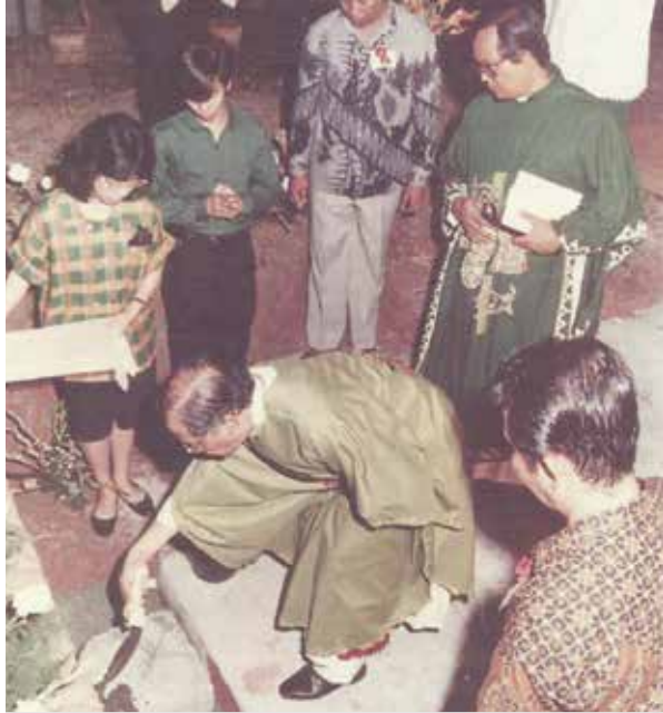
Peletakan Batu Pertama oleh Uskup Agung Leo Soekoto, SJ pada tahun 1988 - [Sumber: Buku Kenangan 25 th Gereja St. Thomas Rasul]
