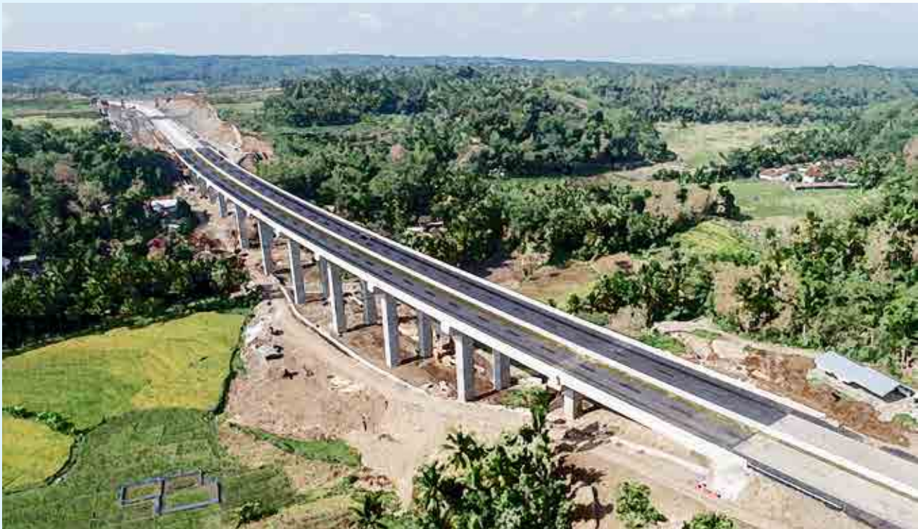
Jembatan Kali Kenteng - Salatiga / Kali Kenteng Bridge - Salatiga
