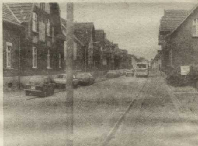
Über diese enge Fahrbahn soll in Zukunft der starke Autobahnzubringerverkehr rollen.
