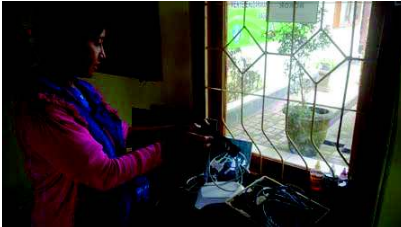
Gambar 4 Pemasangan Perangkat Jaringan pada Ruang Guru
