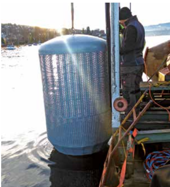
Abb. 7.1.6: Absenken des neuen Fassungskorbes auf 35 m Tiefe zur Montage durch die Taucher.
