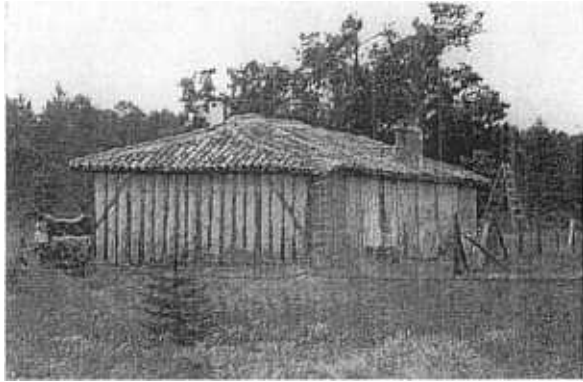
1. Gironde. Maison en colombage couverte de tuile „canales“.
