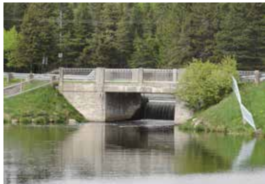
• Le pont des sœurs, en 2011. Collection SHB.
