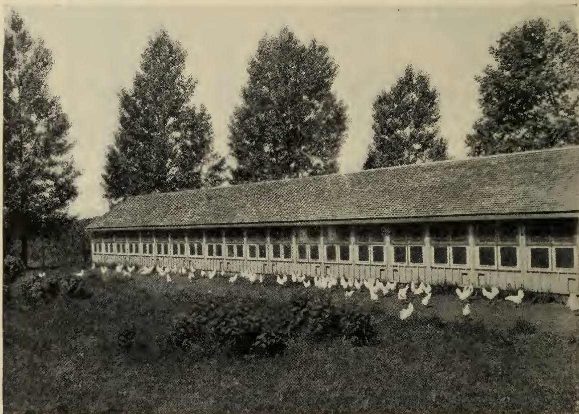
FIG. 6.—Poulailler de reproduction, ferme expérimentale centrale. Ce poulailler est le même en tous points que le poulailler pour cent poules dont le plan et la photographie sont donnés sous l'en-tête "Poulailler de ponte"; la seule exception c'est qu'il est divisé en parquets d'accouplement de six pieds par des cloisons temporaires. Il y a des cours sur le devant et par derrière qui sont cultivées et employées alternativement.
