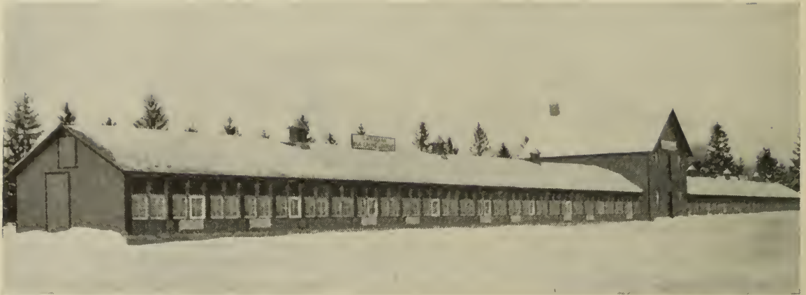
FIG. 9.—Poulailler du concours de ponte canadien à Ottawa. Cette photographie représente le poulailler continu de 16 pieds de profondeur, divisé en parquets de 6 pieds, et pouvant servir comme poulailler de reproduction.
