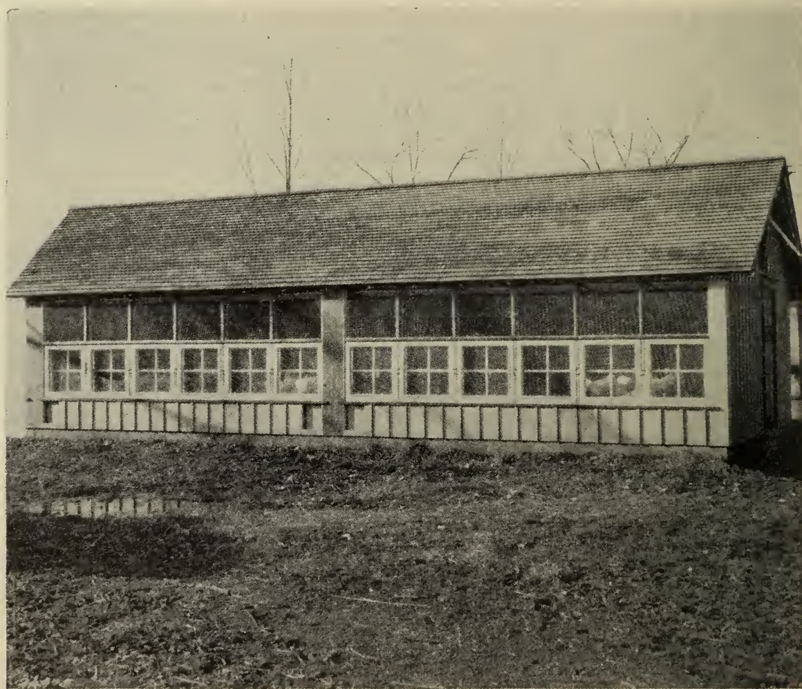
FIG. 1.—Un poulailler de ponte d'un type très avantageux, de 16 pieds par 32 pieds, pour 100 poules des races à toutes fins ou 120 Leghorns. A noter: la porte de ventilation dans le pignon.
