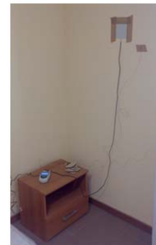
Installazione delle sonde lato interno
