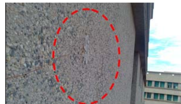
Installazione della termocoppia lato esterno
