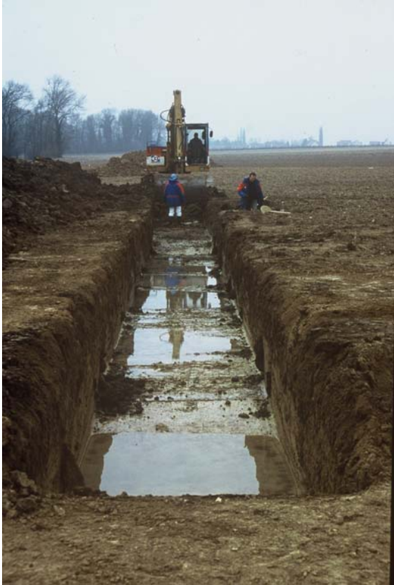
Sondages à la pelle mécanique
