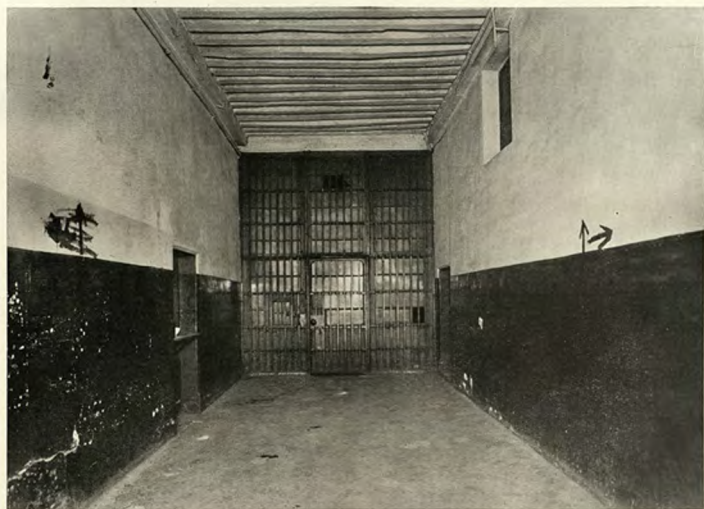
« ...Les murs de Saint Lazare tombaient en ruines... ses parois, badigeonnées au coaltar, avaient perdu leurs anciennes parures... »
