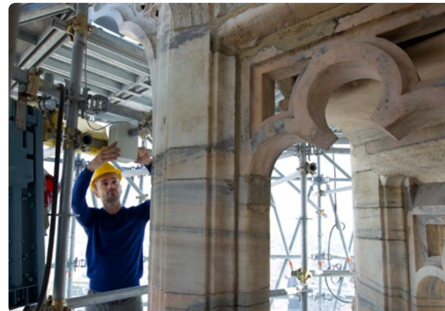
Científicos en Duomo di Milano suben al andamio para hacer ajustes al sistema de monitoreo estructural.
