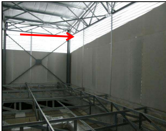
GAMBAR 4.7 Aluminium Louvers Cladding Dibina Sebagai Dinding Bagi Ruang Bumbung
