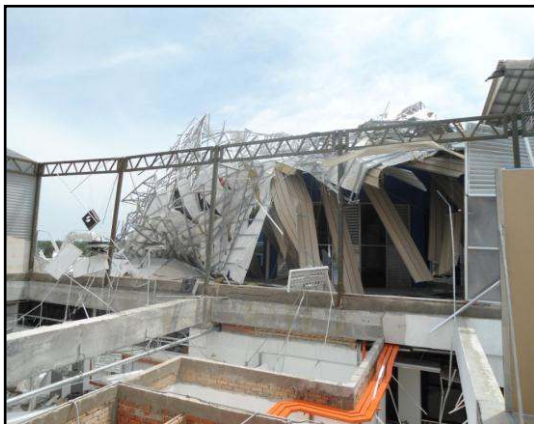
GAMBAR 4.44 Kerangka Bumbung Runtuh
