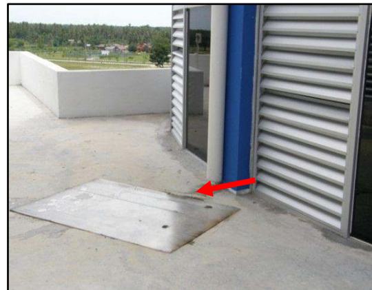
GAMBAR 4.10 Saluran Paip Air Hujan Tidak Dialirkan Terus Ke Scupper Drain
