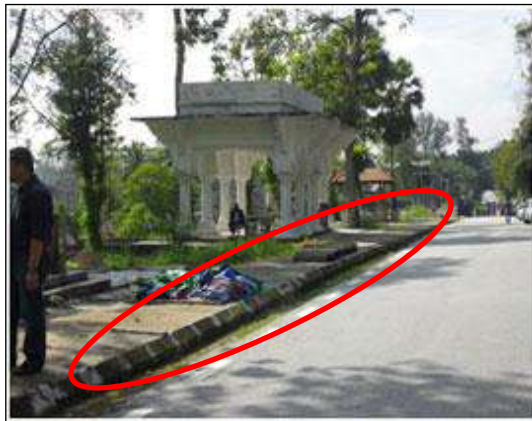
GAMBAR 2.18 Tiada Dinding Adang ( Hoarding ) Didirikan Di Kawasan Pembinaan
