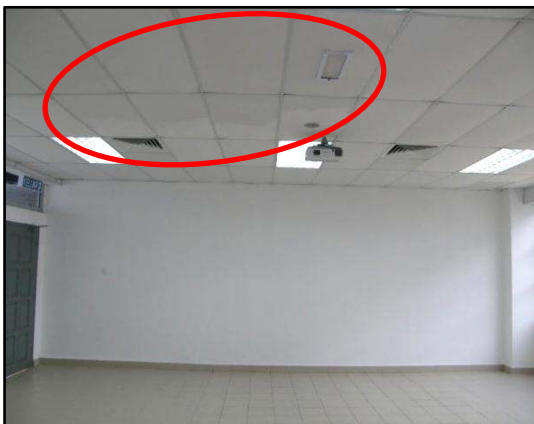
GAMBAR 4.34 Kesan Resapan Air Pada Siling Bilik Tutorial
