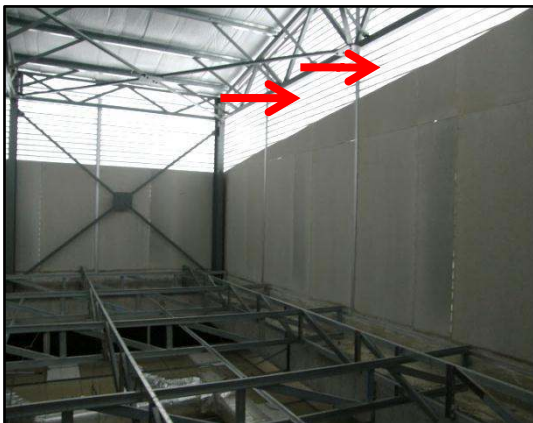
GAMBAR 4.48 Kemas Dinding Ruang Bumbung Menggunakan Aluminium Louvers Cladding
