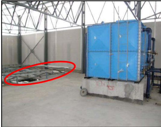
GAMBAR 4.5 Tiada Dinding Penghalang Dibina Bagi Mengelakkan Air Memasuki Ruang Kerja Jika Berlaku Kebocoran Kepada Tangki Air
