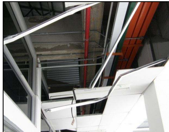
GAMBAR 4.8 Siling Tertanggal Dan Kerangka Siling Rosak Di Luan Bilik Tutorial Di Tingkat 3
