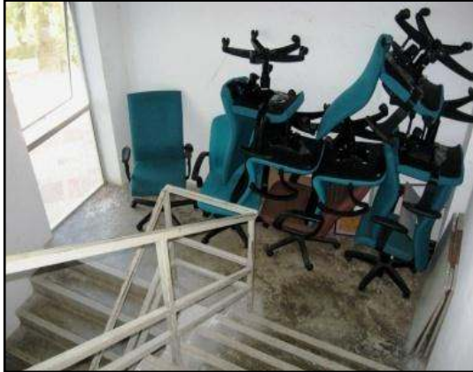
GAMBAR 5.18 Kerusi Rosak Diletakkan Di Laluan Tangga Kecemasan
