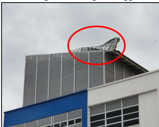
GAMBAR 4.45 Kerangka Bumbung Tertanggal
