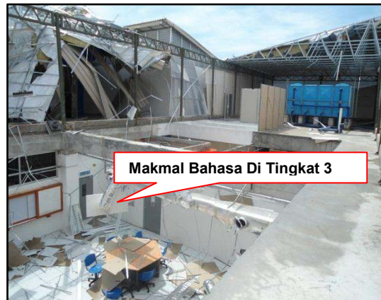
GAMBAR 4.44 Kerangka Bumbung Runtuh
