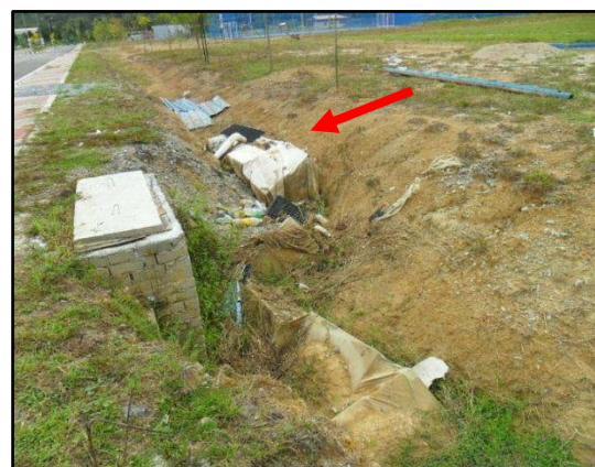
GAMBAR 4.19 Sistem Perparitan Jenis Swale Yang Dipasang Telah Rosak Dan Menjejaskan Aliran Air
