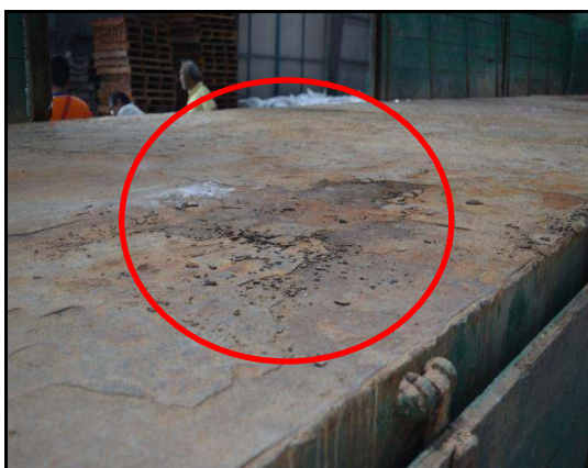
GAMBAR 10.3 Keadaan Lantai Lori Yang Berkarat Dan Permukaan Lantai Yang Tidak Rata
