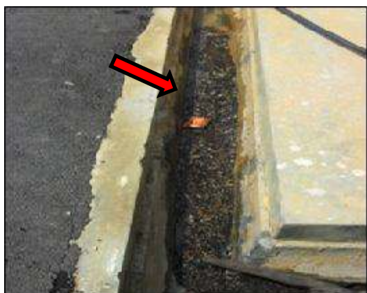
Lokasi : Tapak Projek Substation TNB Tarikh : 6 Disember 2012
