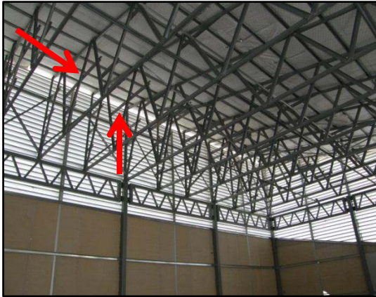
GAMBAR 4.47 Pemasangan Anggota Kekuda Bumbung Yang Tidak Sempurna
