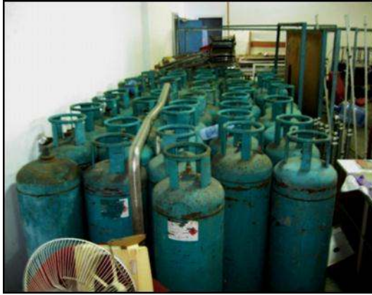
GAMBAR 5.7 Tong Gas Yang Tidak Digunakan
