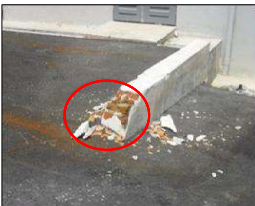
Lokasi : Tapak Projek Substation TNB Tarikh : 6 Disember 2012
