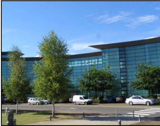
Lokasi: Bangunan Reading International Tarikh: 14 September 2012
