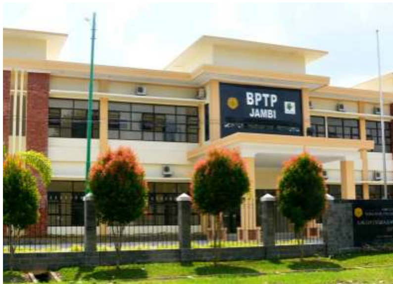
Gambar 7 . Bangunan Kantor Kotabaru (Tampak Depan)
