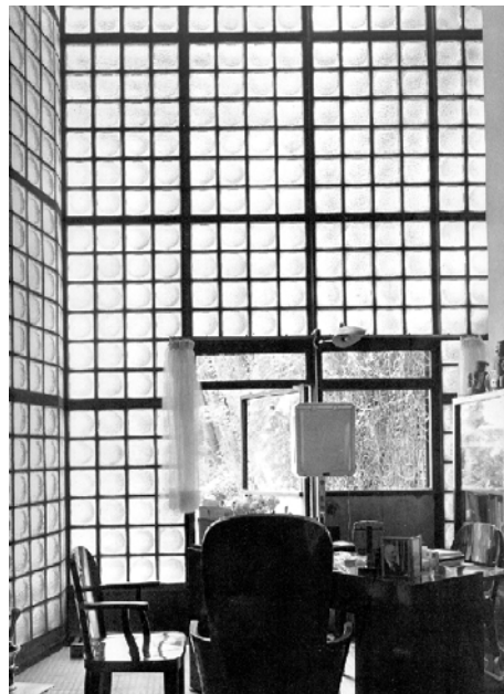
Figura 13.4. En este sector de la Maison du verre de Pierre Chareau predomina el uso de vidrio translúcido, que permite una excelente iluminación natural sin afectar la sensación de privacidad.
