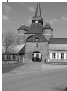
Eglise de Parfondeval (photo : M.P. Bouleau)
