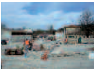
Travaux place du bourg
