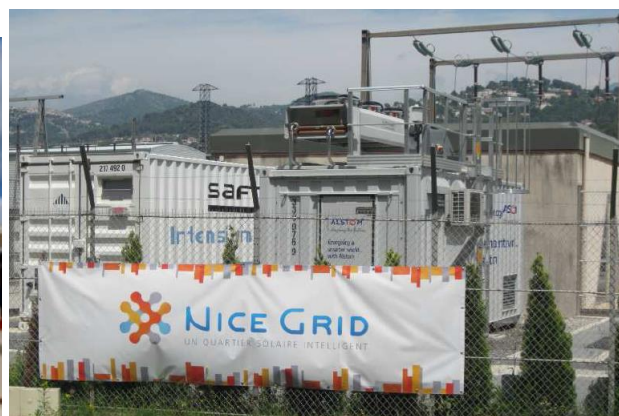
Image 2. Système de stockage d'électricité sur le poste source de Broc Carros, dans le projet Nice Grid
