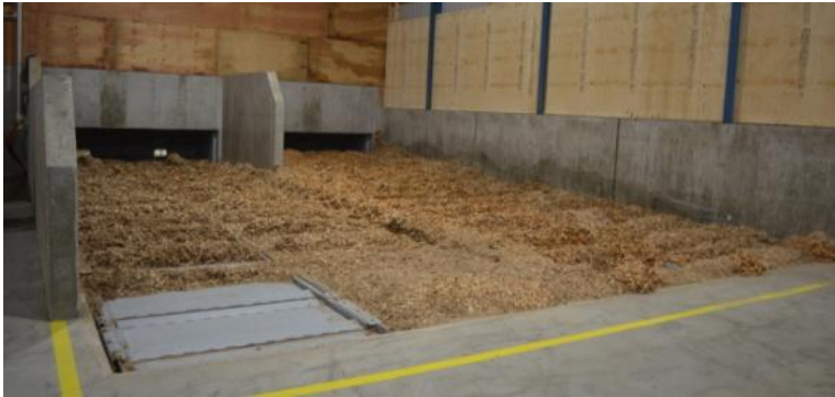
Extracteur à poussoir hydraulique
