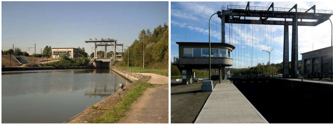
Figure 32 : Vues du site éclusier de Viesville (sources: flickr)
