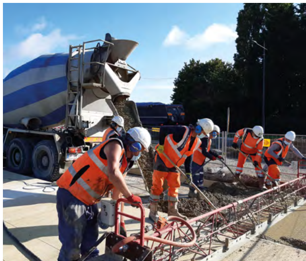
▲ Mise en œuvre du béton à la règle vibrante par demi-chaussée pour constituer la voie avec un profil en toit.
