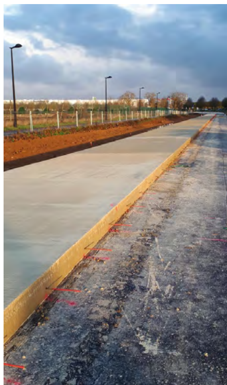
▲ Afin de maintenir fermé le joint longitudinal, des fers de liaison ont été insérés dans le béton frais avec un espacement d'un mètre.
