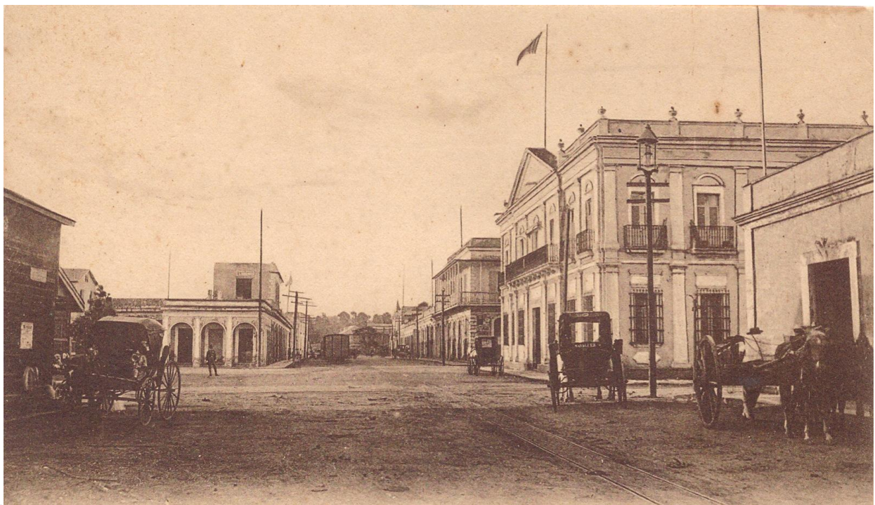
Calle Real del Comercio (Hoy Ave. José González Clemente) en el Barrio de La Marina Meridional
