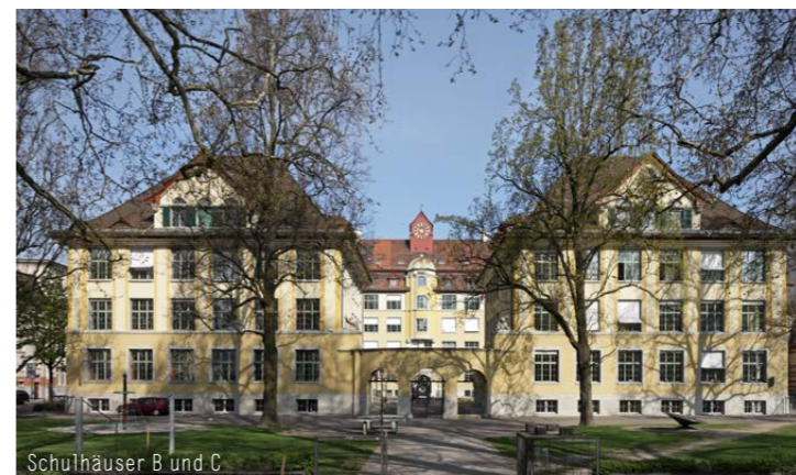
Schulhäuser B und C
