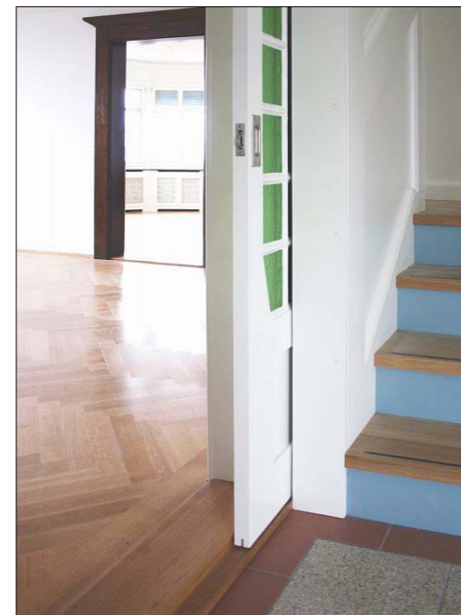
Die neue, interne Treppe, Schiebetüre aus alten Bauteilen
