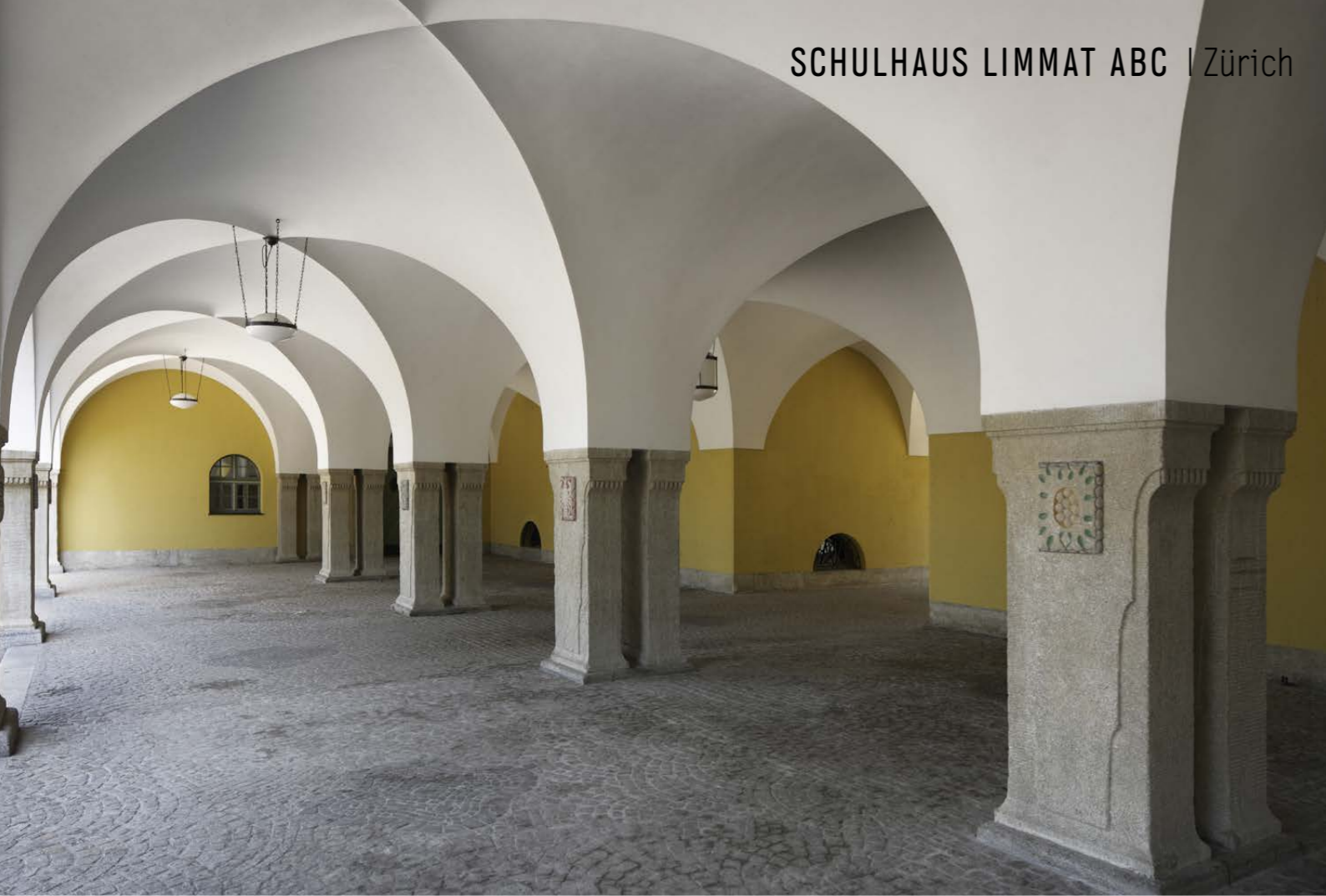
Sanierte Eingangshalle mit freigelegtem Boden, neu vergipstem Gewölbe, restaurierten Malereien, neuem Wandputz, sanierten Fenstern und neuen Leuchten
