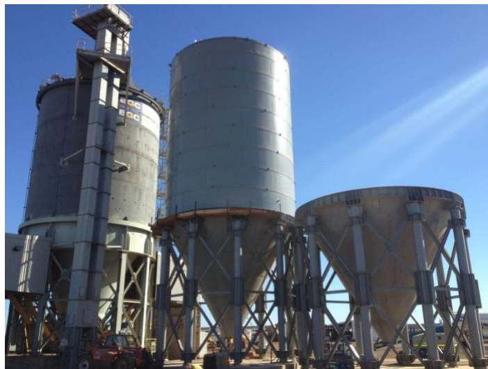
Gambar 3.4 Penyimpanan Bahan Baku di Dalam Silo
