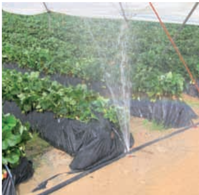
Detalle de pérdida de agua en conducción
