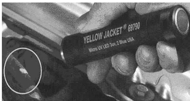
Detección de fugas con fluido fluorescente en luz UV.
