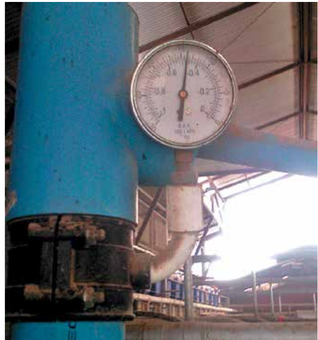
El arte de la regulación del vacío y la pulsación está en que deben ser igual tanto para una sola vaca ordeñándose, como para todas las unidades ocupadas al mismo tiempo.
